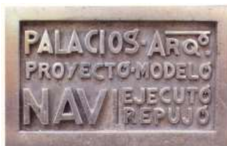
171.- Placa de autoría del edificio.
